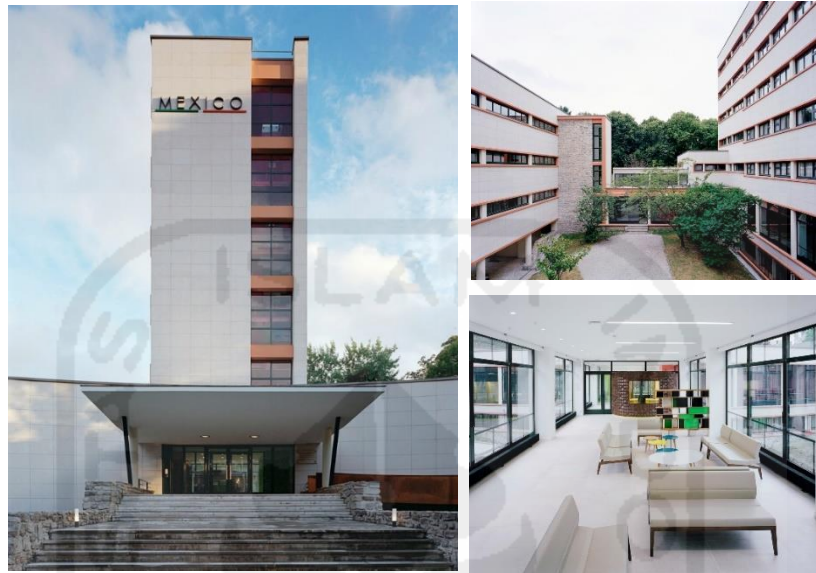
Gambar 2-34 Maison du Mexique Rehabilitation sumber : archdaily.com
