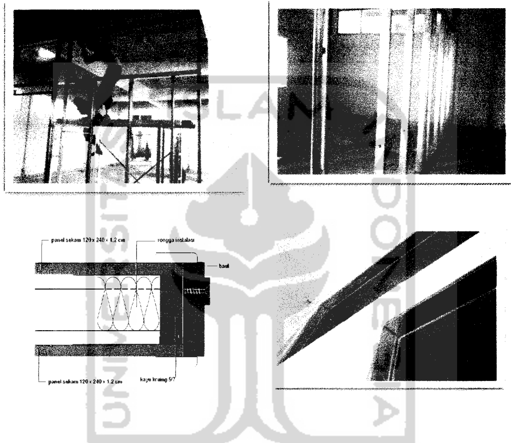
Gambar 4.7: Pemasangan Panel dilapangan
