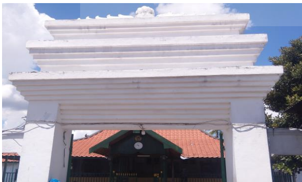
Gapura masuk Komplek Masjid Pathok Negoro Plosokuning dengan bentuk paduraksara
