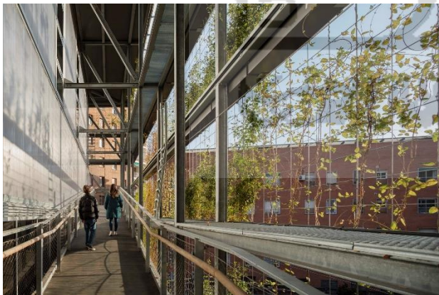
Gambar 2.70 Ramp Difabel Pada Sisi Bangunan (Sumber : Archdaily, 2019)
