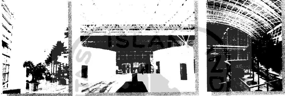
Rangka atap dengan space frame
