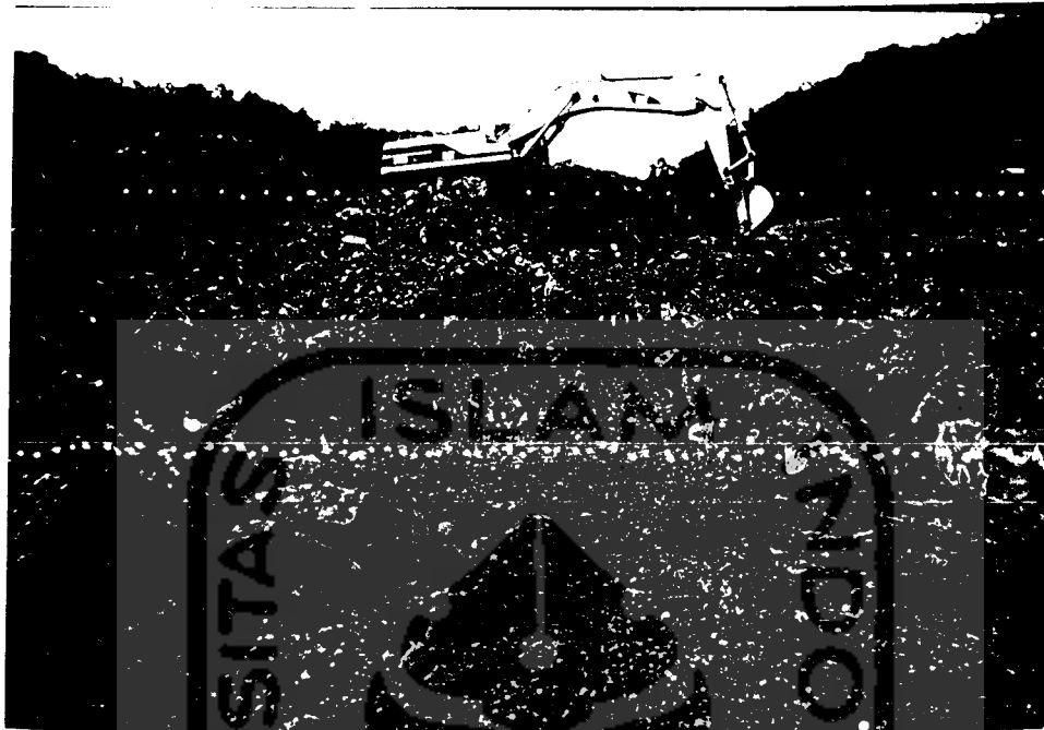
Gambar 3.4. Excavator Cat 330 B
