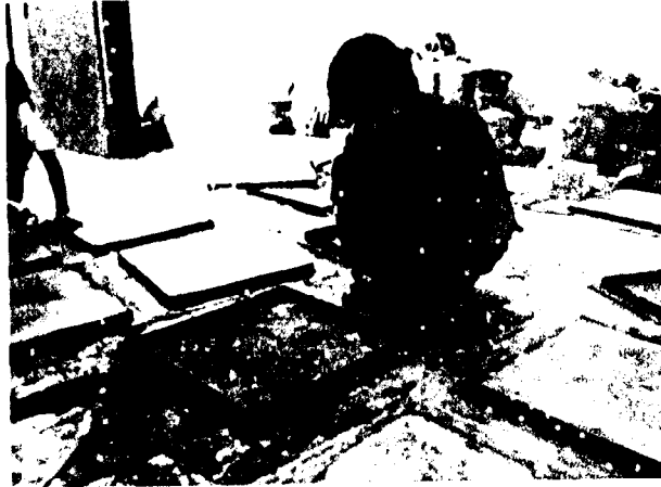
Gambar 13. Pelepasan Bekisting Sampel
