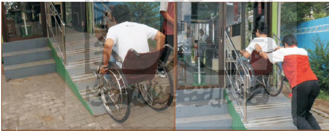
Gambar 1.2 Ramp Yang Terlalu Curam
