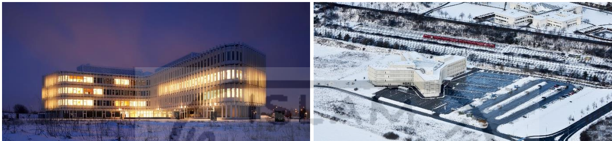
Gambar 2.71 Tampak Luar Bangunan
