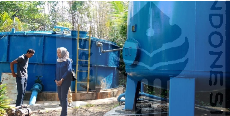
2. Survey Instalasi penjernihan Air Kadisono, Tridadi
