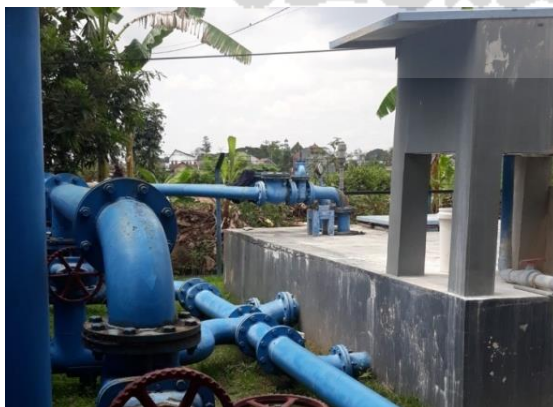
Gambar 4.4 (a) Bak Disinfeksi dan Reservoir
