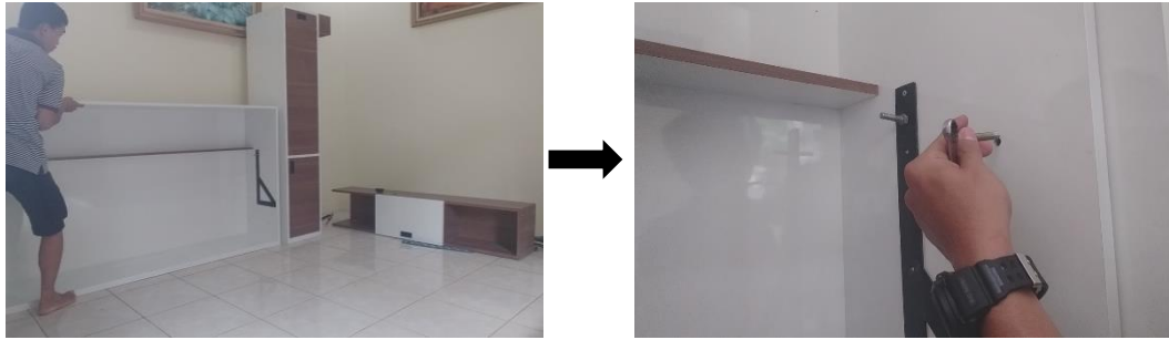
Gambar 4-24 Proses Pemasangan Baut dan Mur
