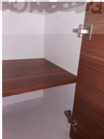
Gambar 4-29 Pemasangan Engsel pada Pintu Almari
