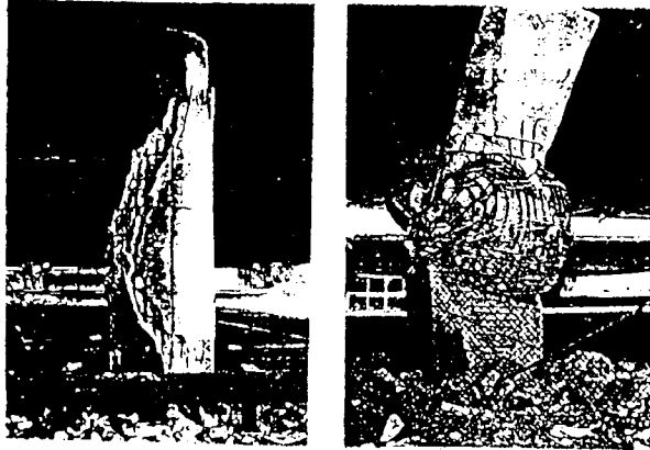
Gambar 2.6 Kerusakan kolom akibat geser
