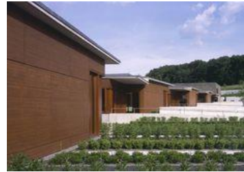
Bagian belakang bangunan
