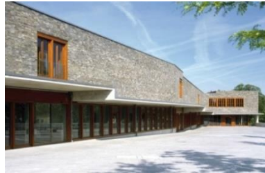
Bagian depan bangunan
