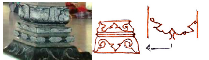
Gambar 4.7.7 Pondasi Masjid Agung Demak (Sumber : M Zakki, 2017)
