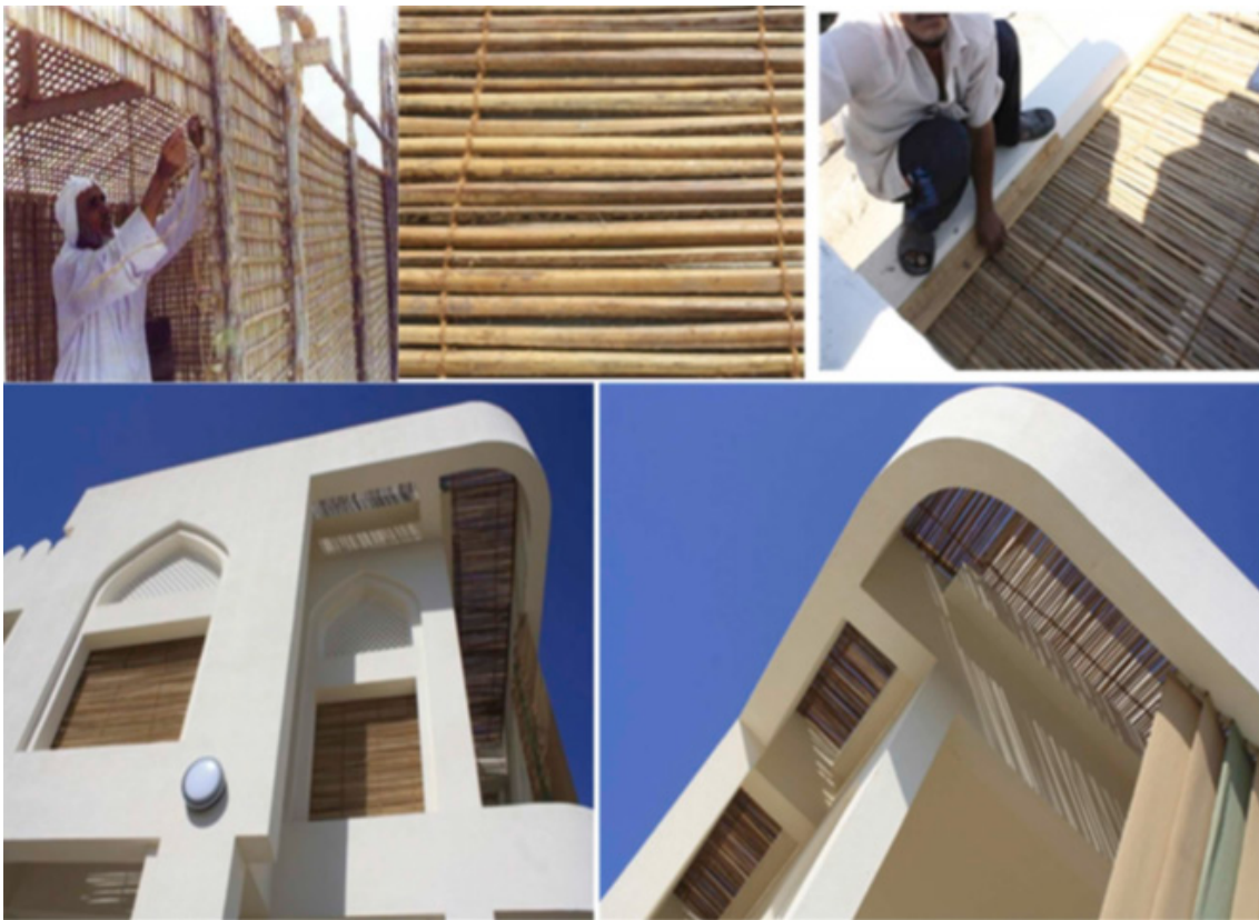
Gambar 3.23 shading dari batang pohon kurma pada wall-shell eksternal dan pinggiran atap Sumber : (Al-Saadi & Shaaban, 2019)
