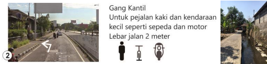
Gambar 3.12 Kondisi Akses Gang Kantil
