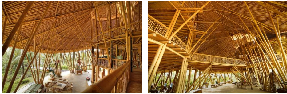
Gambar 2.34 Struktur Bambu Terpusat dan Ruang yang Luas Sumber: ibuku.com, 2020
