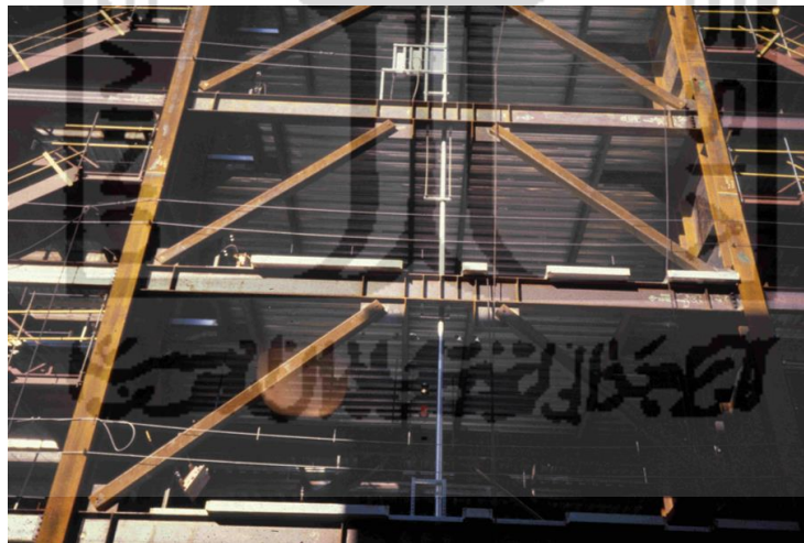
Gambar 2. 3 Penerapan SRBE K-shape di konstruksi
