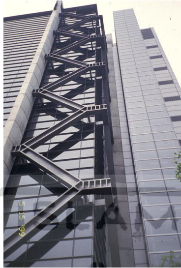
Gambar 2. 4 Penerapan SRBE D-shape di konstruksi
