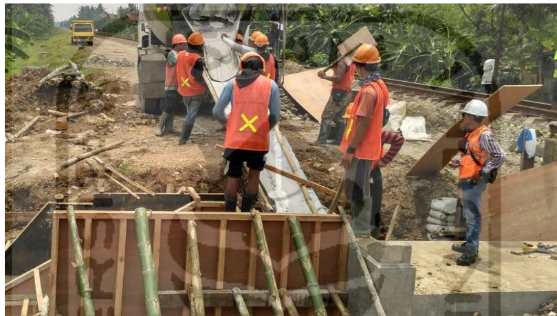
Gambar 5.6 Pekerjaan Pengecoran Beton (1)
