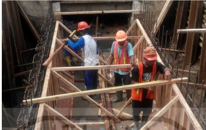
Gambar 5.3 Pekerjaan Pemasangan Bekisting (1)
