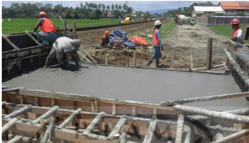
Gambar 5.8 Pekerjaan Pengecoran Beton (3)
