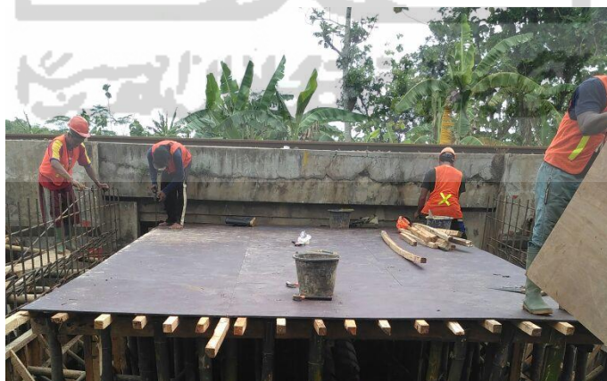
Gambar 5.5 Pekerjaan Pemasangan Bekisting (3)
