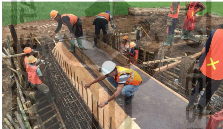
Gambar 5.2 Pekerjaan Pembesian (2)
