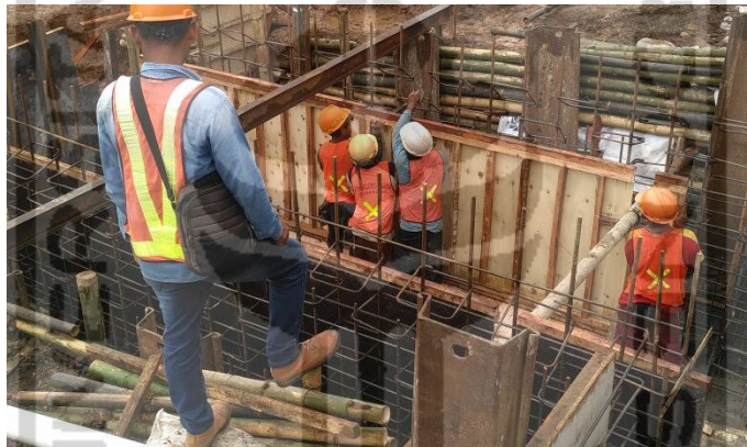
Gambar 5.4 Pekerjaan Pemasangan Bekisting (2)
