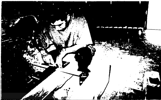
Gambar L 7.10: Pengukuran dan pemotongan TFC
