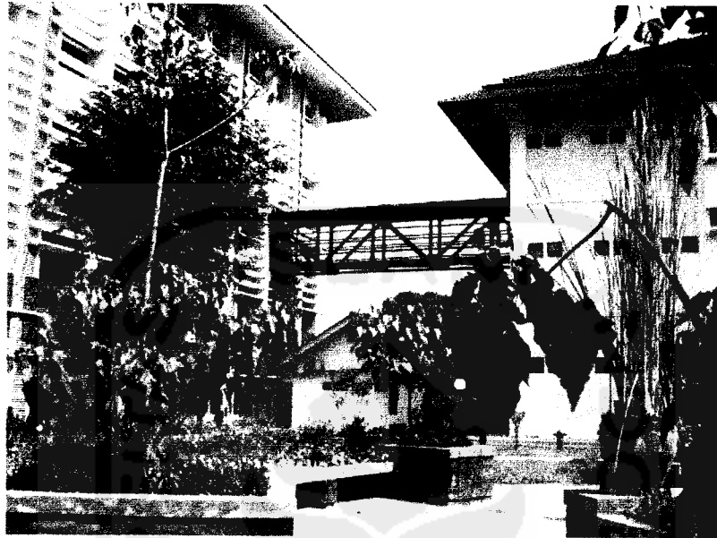
Gambar 2.4 Jembatan penghubung antara bangunan baru (kiri) dengan bangunan lama (kanan) Sumber : Hasil Survei
