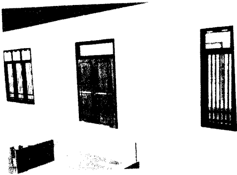
Pintu Ruang Makan/ Televisi
