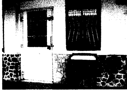
Gambar Pintu-Jendela Pada Ruang Isolasi
