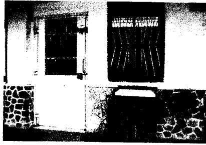
GAMBAR IV.4 Pintu, Jendela dan Ventilasi Ruang Isolasi
