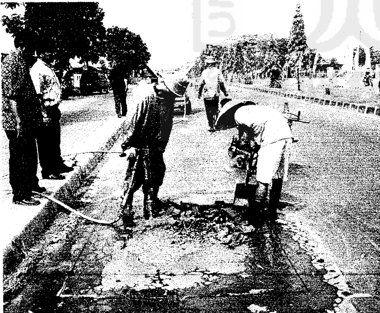
Bagian tengah dibongkar dg Jack Hammer / Jack vibrator
