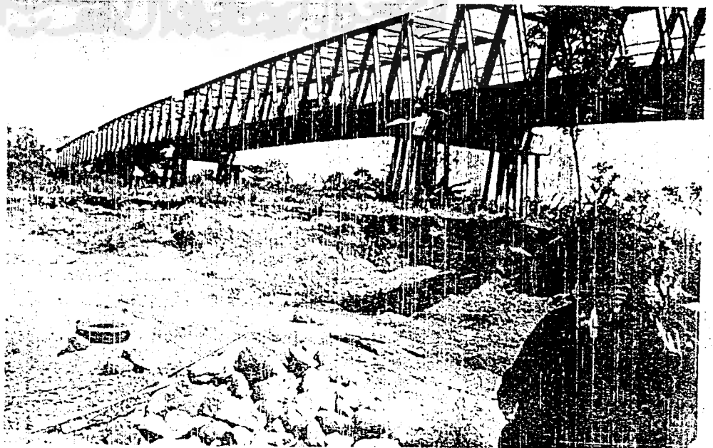
Lubang-lubang penambangan pasir persis di bawah Jembatan Kretek.
