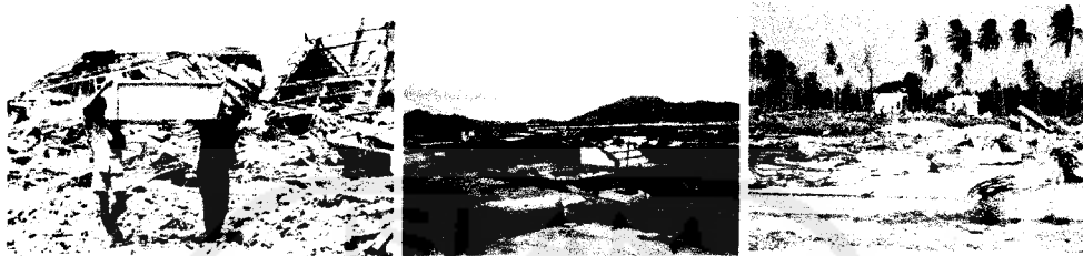
Gb.3.2 Kerusakan akibat bencana gempa bumi dan tsunami di daerah Kaju Kabupaten Aceh Besar Sumber: Dokumen Pribadi
