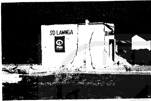
Gambar 1.3 Kondisi sekolah yang telah rusak parah akibat tsunami di daerah Kaju Aceh Besar Sumber : Dokumentasi Pribadi
