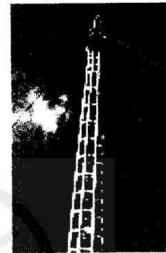
Struktur kabel sebagai struktur utama penyangga beban atap dome. yang ditonjolkan agar menimbulkan nilai estetis
