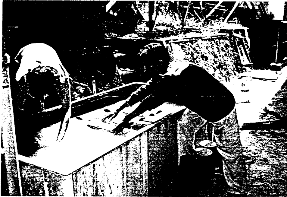
Gambar 3. Perawatan beton dengan perendaman air
