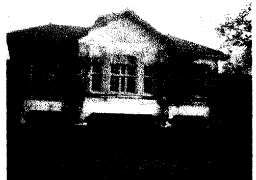
Gb.18. Tampak bangunan kini
