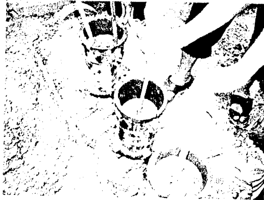
Gambar 14 Penuangan dan Pemasatan Adukan Beton dalam Cetakan
