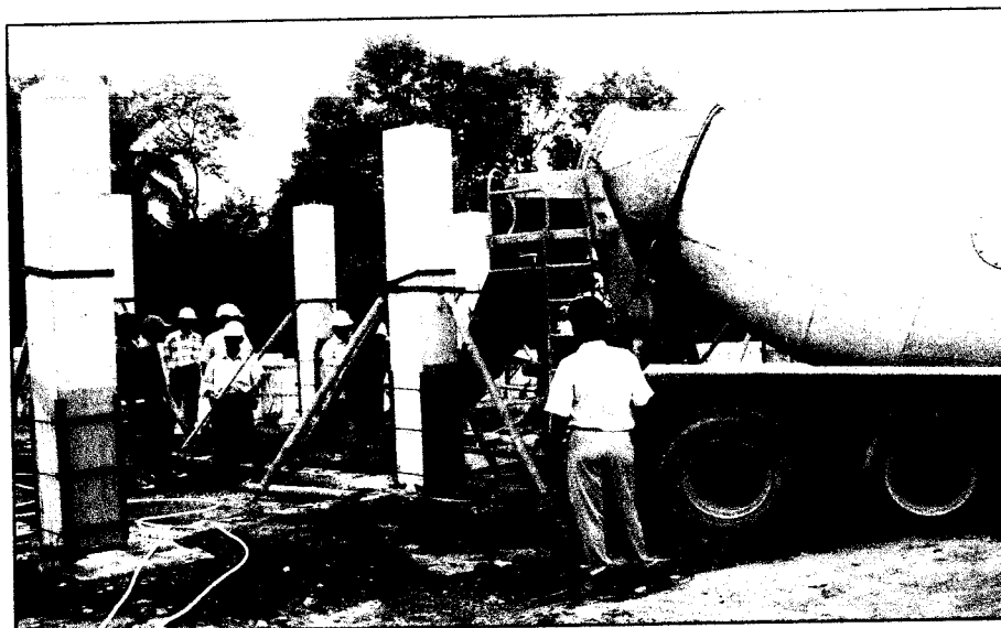
PENGECORAN GROUTING KAKI KOLOM
