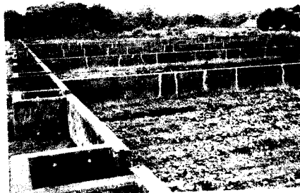
Gambar. 2.1. Sludge Drying Bed Pada Instalasi Pengolahan Air Buangan Limbah (IPAL) Domestik Sewon, Bantul
