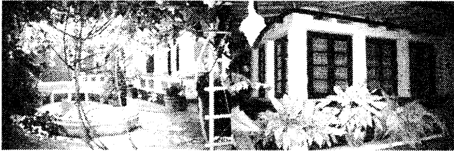
Gbr. II.10 Taman dan beranda sebagai tempat interaksi sosial antar keluarga Pada bangunan saudagar besar dan sedang (data survey lapangan)
