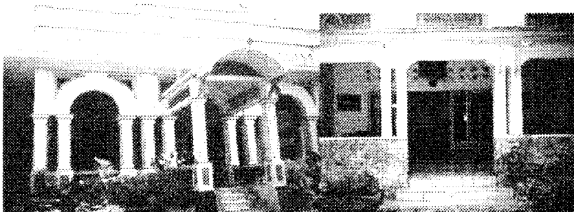
Gbr. II.7 Asas simetri pada Bangunan kolonial (data survey lapangan)
