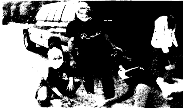
Gambar 3.4. Proses Pengayakan Lumpur
