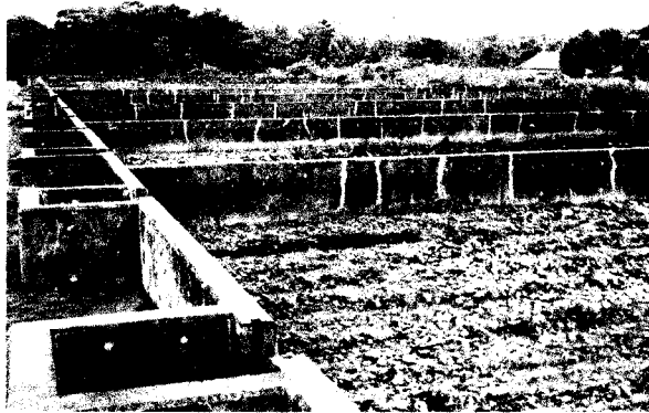
Gambar 1. SDB (Sludge Drying Bed) tempat pengambilan lumpur yang digunakan dalam pengomposan di IPAL, Sewon, Bantul
