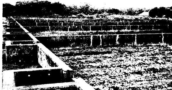
Gambar 3.1. SDB ( Sludge Drying Bed ) Pada Instalasi Pengolahan Air Limbah ( IPAL ) Domestik Sewon Bantul
