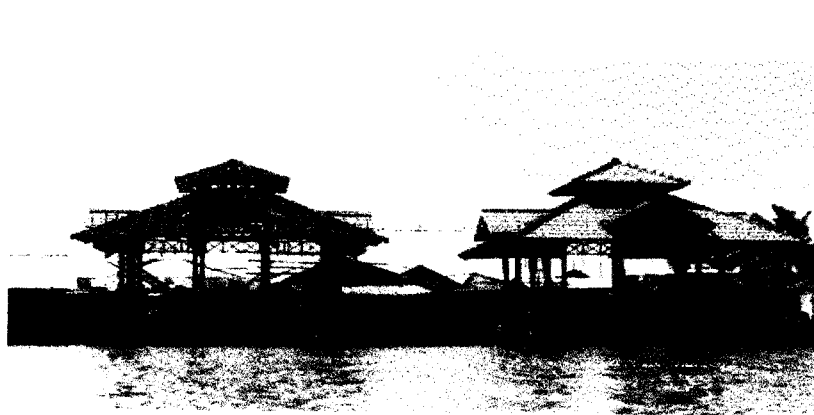
Gambar 2. 5. Bangunan local Segara Anakan ( terapung )
