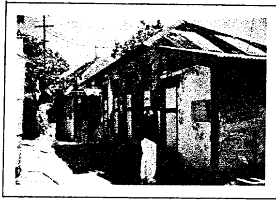
Gambar II.9 : KM / WC pulau Kayangan Sumber : dokumentasi
