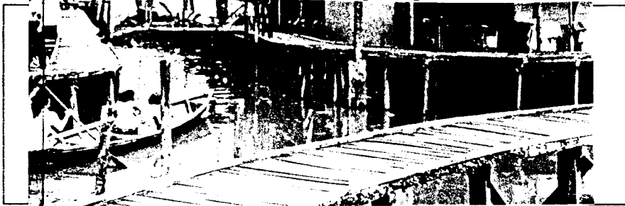
Gambar. 4.16 Salah Satu Jembatan Penghubung di Perkampungan Kuin Utara Sumber : Survey
