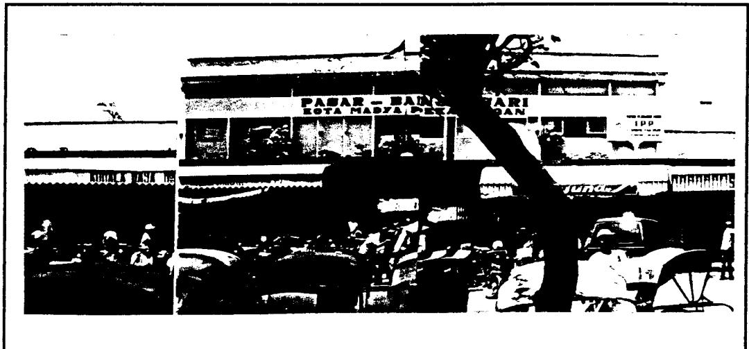
Gambar 2.5. Kondisi Fisik Pasar
