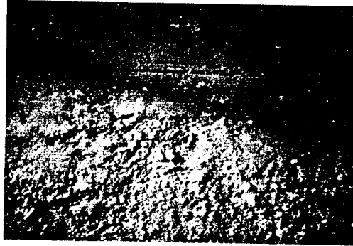
Gambar 2.8: Pelepasan butir ( raveling ) Sumber : Lokasi Penelitian 2005
