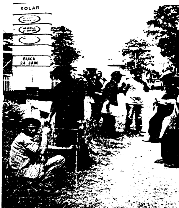
Gambar 1 : Pengukuran CBR lapangan menggunakan DCP pada bahu jalan.
