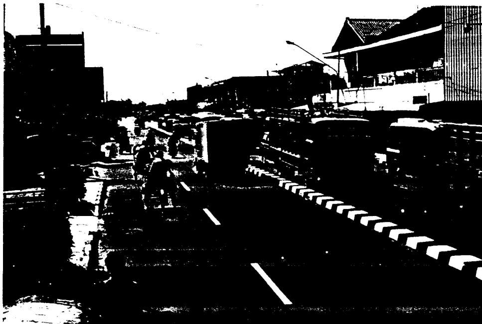
Gambar 5.36 Kondisi Hambatan Samping Jalan Perintis Kemerdekaan
