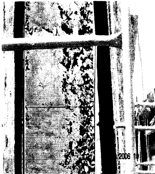
Gambar 1.1 Contoh hasil pengecoran yang keropos pada kolom
