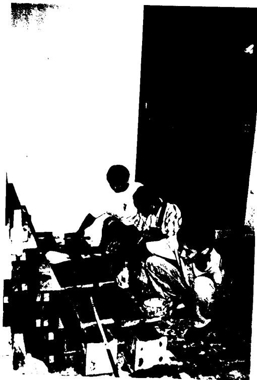
Foto 6 Adukan dimasukkan kedalam bekisting yang telah dipersiapkan dengan berlapis dan tiap lapis ditumbuk dengan tongkat penumbuk sampai padat.
