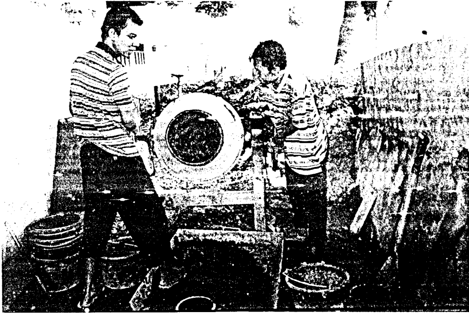
Foto 3. Pencampuran adukan beton dengan molen listrik
