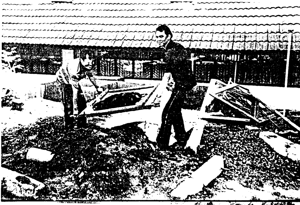
Foto 1. Mengayak pasir yang dilakukan secara manual
