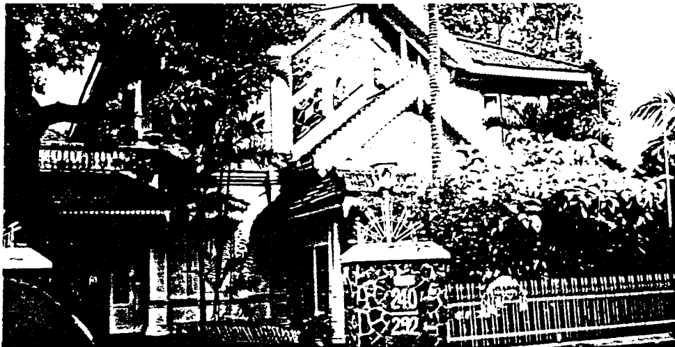
Gambar 2.12 Rumah Tinggal di Jl. Slamet Riyadi Sumber : Survey Lapangan
