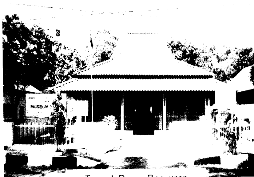
Tampak Depan Bangunan
