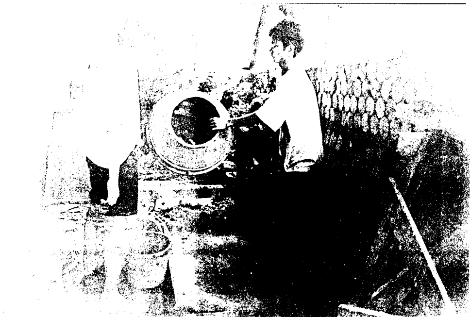
Pengadukan Campuran Material Beton
