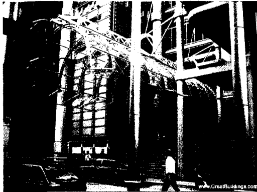
Gedung perkantoran di Inggris yang menggunakan elemen pabrikan dalam bangunan (baja)
