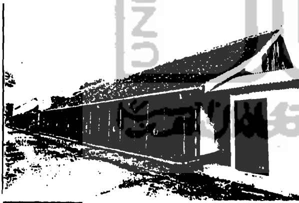
Foto Nomor 82/100402 Kondisi bangunan sebelah utara bangunan induk, dilihat dari tenqgara
