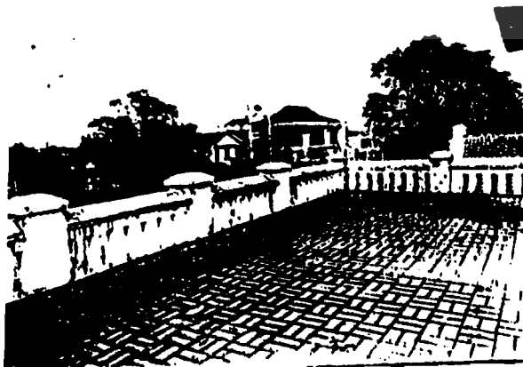
Foto Nomor 53/100357 Kondisi teras lantai balkon bangunan induk, dilihat dari tenggara.
