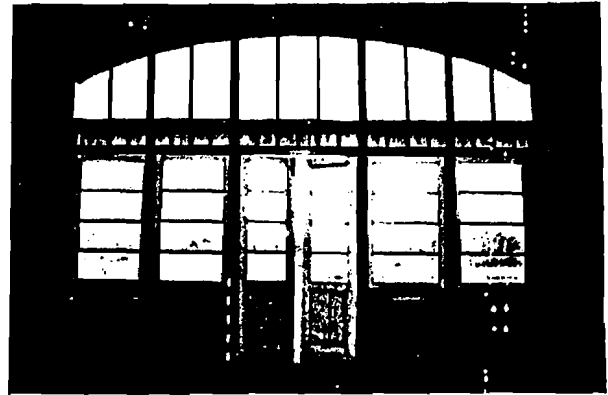
Foto Nomor 56/100359 Kondisi pintu masuk ruang balkon tampak dalam.
