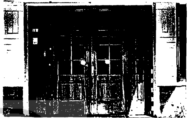
Foto no.77/100440 Kondisi pintu masuk ruang de- pan (R1) sisi barat, tampak luar, dilihat dari barat
