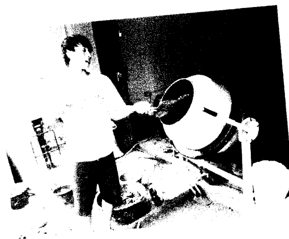
Proses Pengadukan Beton
