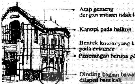
Dinding bagian bawah dilapisi batu kali, kolom/pilar yang kokoh menonjol pada bagian entrance serta pada samping pintu, dimensi pintu/jendela dengan ukuran besar dan tinggi, boven-licht berupa glas-in-lood bermotif bunga, penutup atap genteng.
